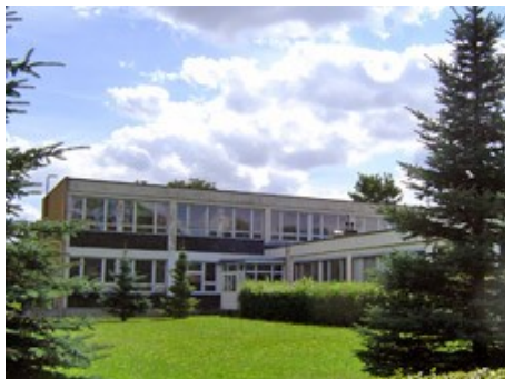
Gebäude des Kinder- und Jugendnotdienstes Chemnitz
